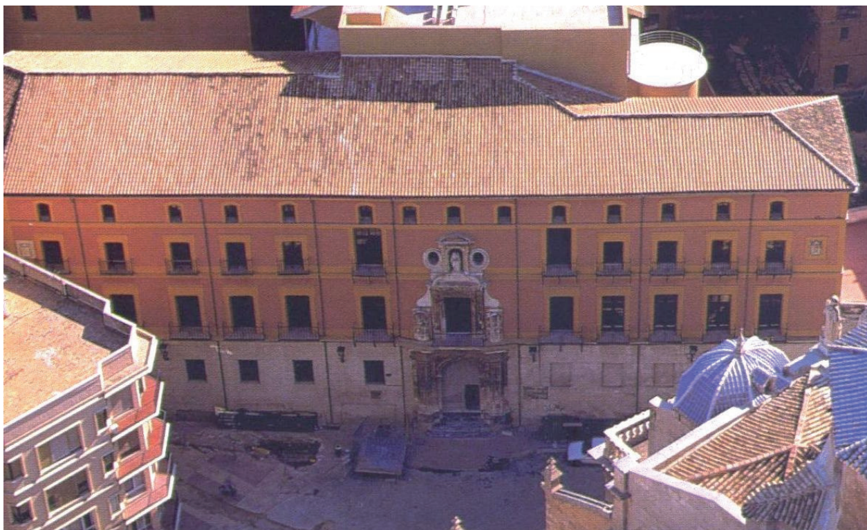
Vista aérea del edificio en obras desde el noroeste.
